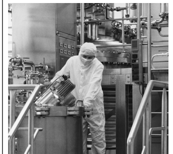
Anlage in der Pharmaindustrie
